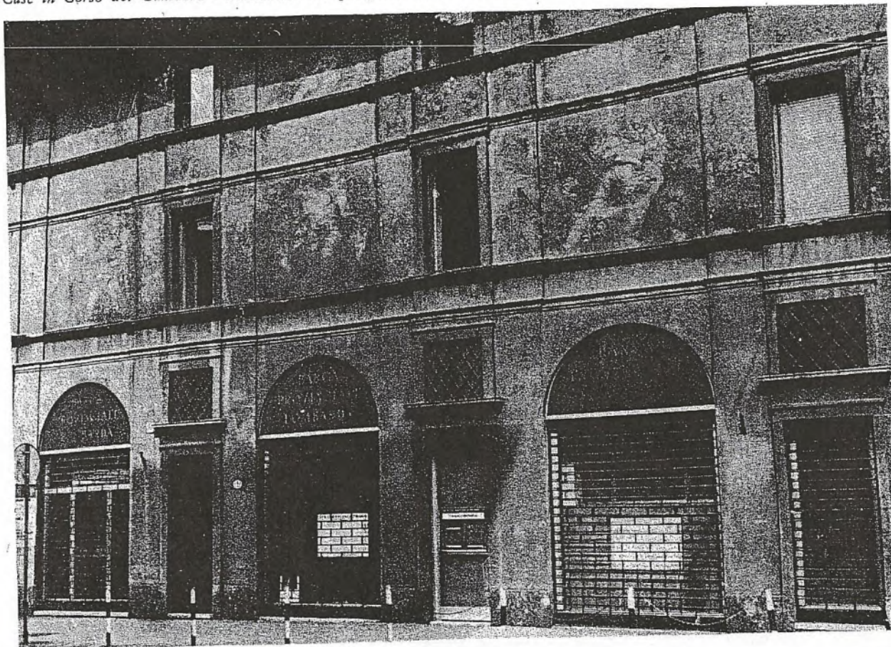
Case in Corso del Gambero - Particolare del prospetto verso via Larga.
